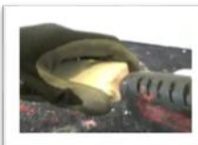
شكل (٤٥) وضع الغراء الساخن بالفتحات
